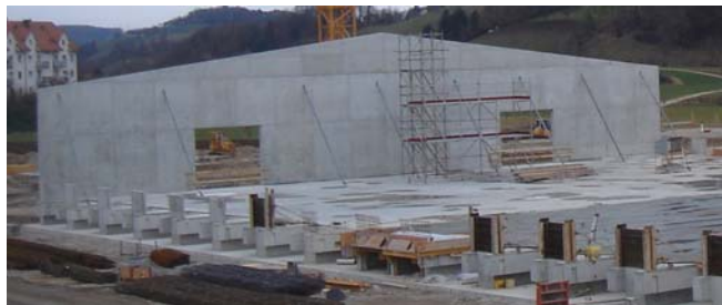
Die filigrane Tragkonstruktion
